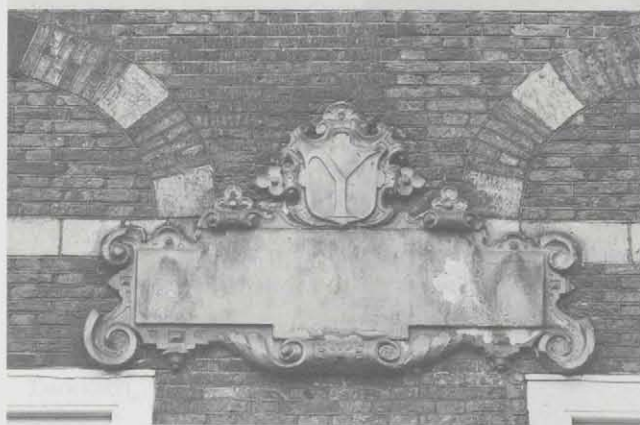
1. De gevelsteen uit 1616, thans in Oude Delft 169 (foto René van der Krogt, november 1983).
